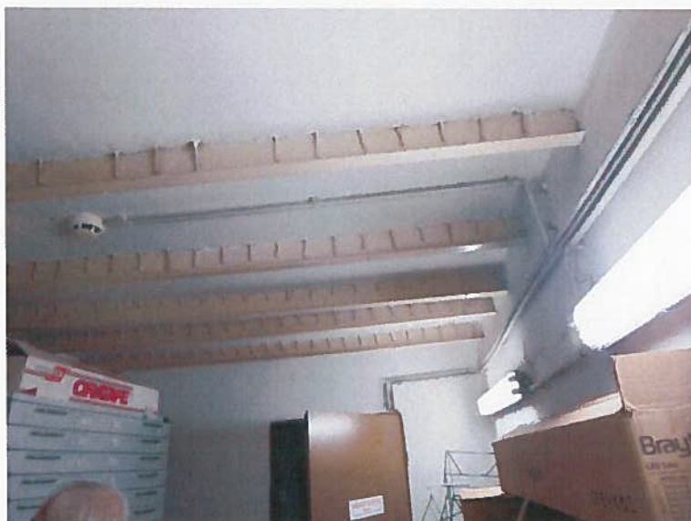
Slika 5: Raven (najverjetneje betonski) strop na jeklenih nosilcih v kleti
