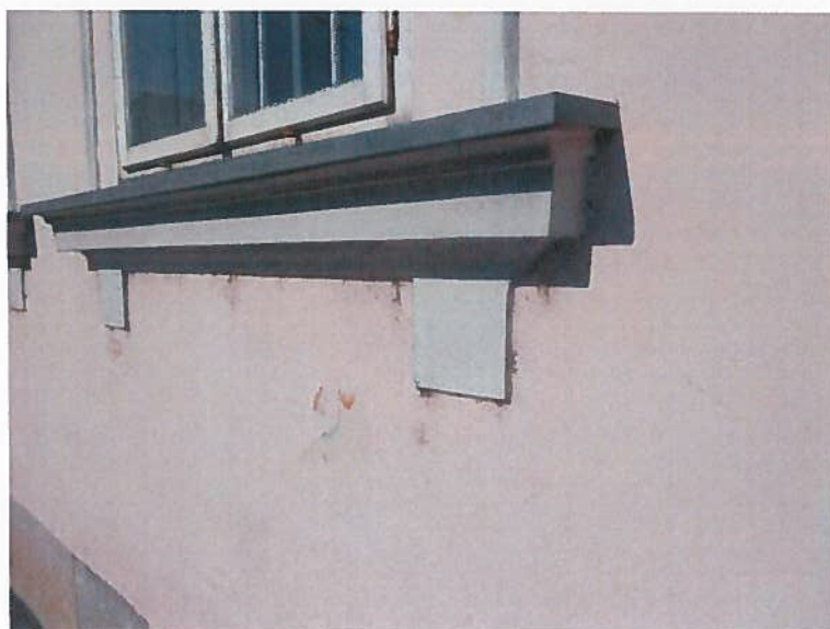
Slika 15: Lokalno odstopanje fasadnega opleska
