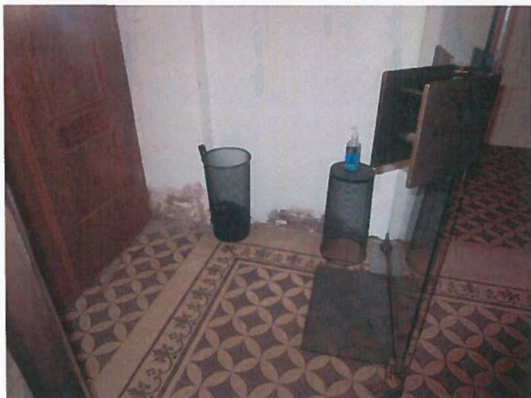
Slika 10: Poškodbe v ometu zaradi prekomerne vlage v zidovih pritličja
